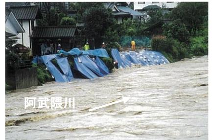
河岸崩壊の拡大を防ぐシート張り (福島市)
