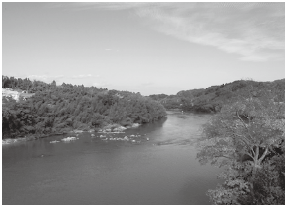
▲鬼生田橋付近（郡山市日和田町・西田町）
