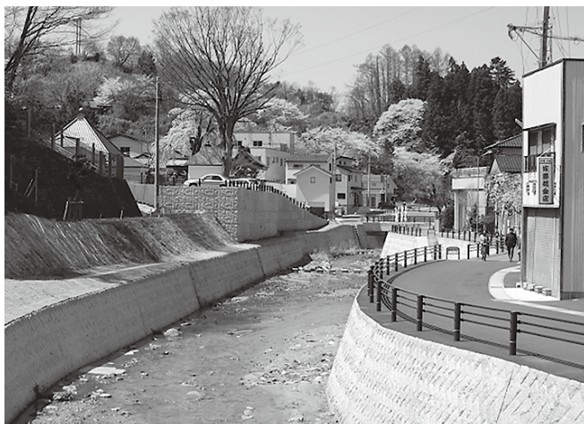
桜川河川改修事業（三春町）
