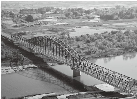
▲ランドマーク的な役割が期待される丸森大橋
